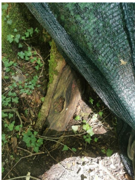
Slika 3.10.1. Oštećenje pridanka na plohi br. 109
